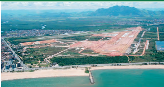
Construção novo terminal de passageiros
