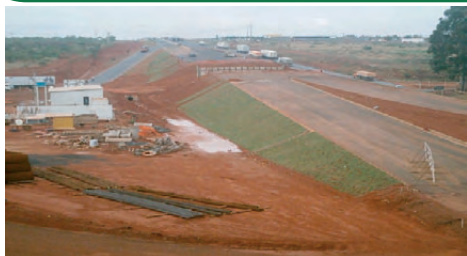
Execução de viaduto em Uberlândia
