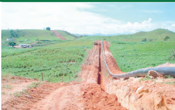
Gasoduto Campinas - Rio
