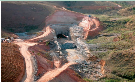
Desemboque do túnel 3
