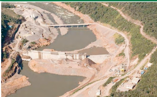
Vista aérea do canteiro de obras
