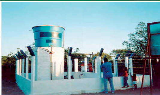
Sistema Simplificado de Abastecimento de Água
