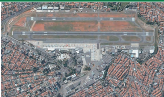
Recuperação da pista principal
