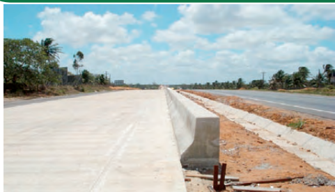
Pista em concreto de cimento com barreira New Jersey
