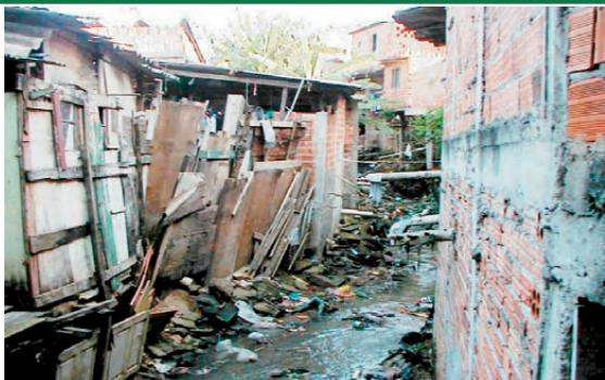
Moradias às margens de córrego na Favela de Heliópolis
