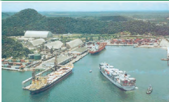
Porto de São Francisco do Sul-SC
