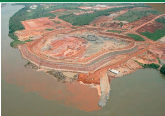
Vista das escavações e desvio do rio
