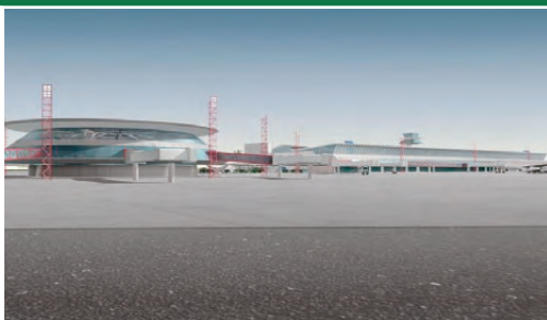
Construção do satélite sul
