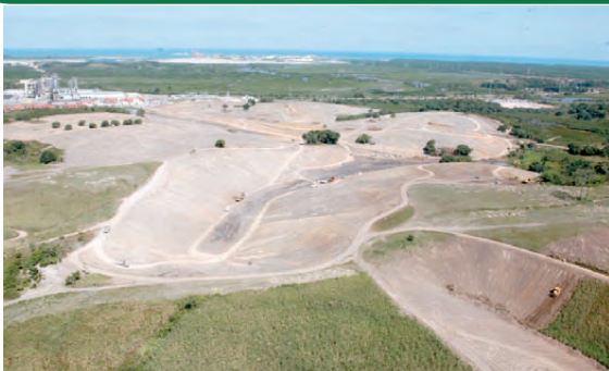
Refinaria Abreu e Lima - terraplanagem
