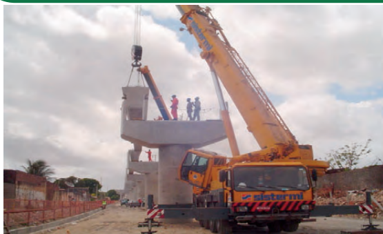
Montagem de vigas no Viaduto Parangaba
