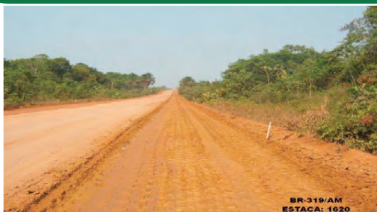
Regularização de subleito
