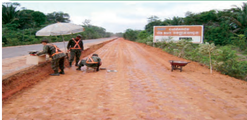
Regularização de subleito
