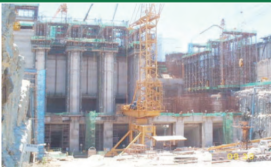
Vista da Casa de Força
