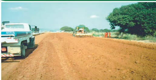
Terraplenagem da pista nova na BR-101
