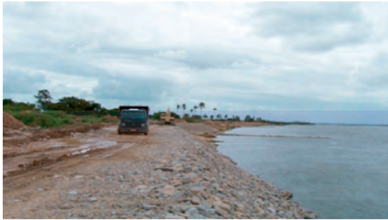
Contenção de erosão na margem do São Francisco
