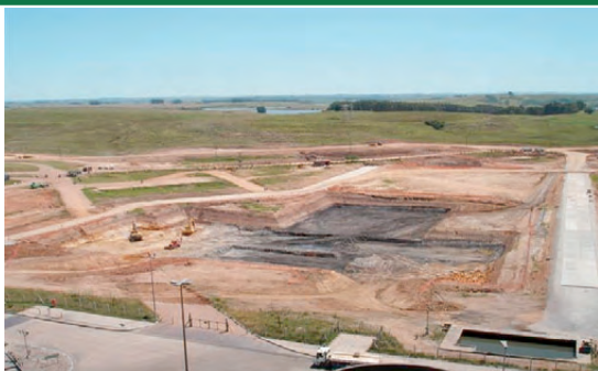
Vista do canteiro de obras
