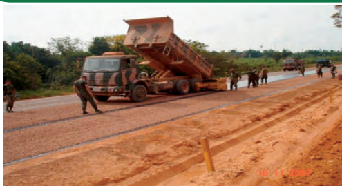
Km 914 – execução da pavimentação
