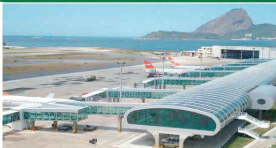
Ampliação do terminal de passageiros
