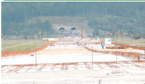
Túnel do Morro Alto – emboque norte
