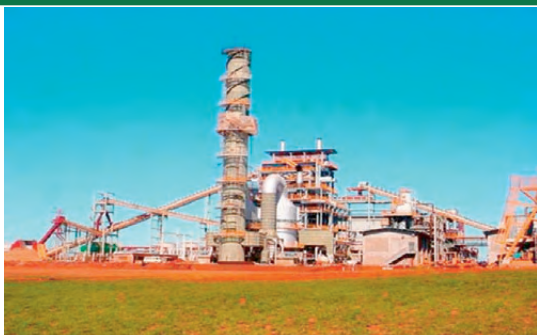
Vista geral da usina
