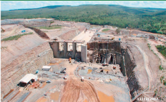
Vista aérea do canteiro de obras
