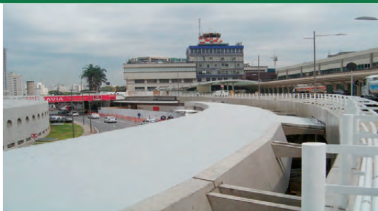
Construção torre de controle
