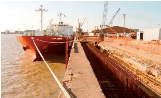
Cais do Porto de Itaqui
