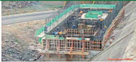
Obras da Eclusa 1
