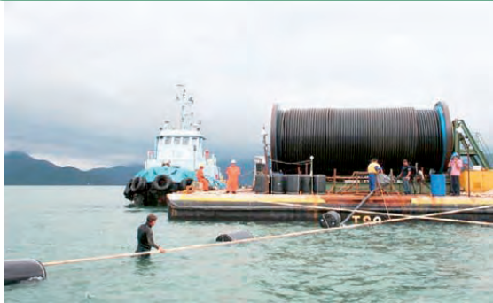
Lançamento do Cabo
