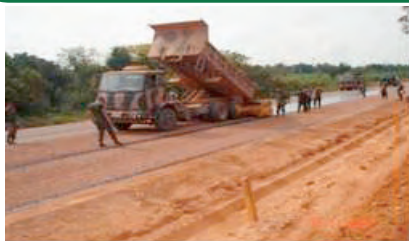
Km 914 – execução de pavimentação
