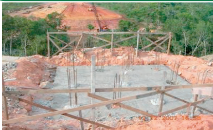
Construção da Ponte sobre o Rio Feio – Km 480
