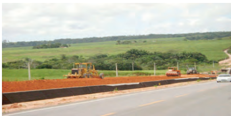
Serviço de terraplenagem
