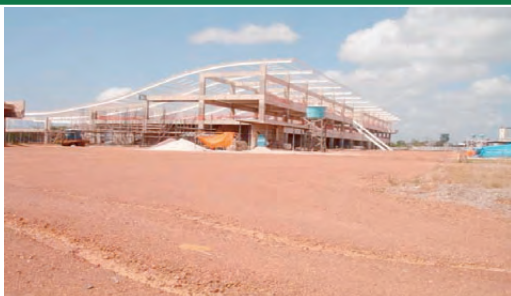
Construção novo terminal de passageiros
