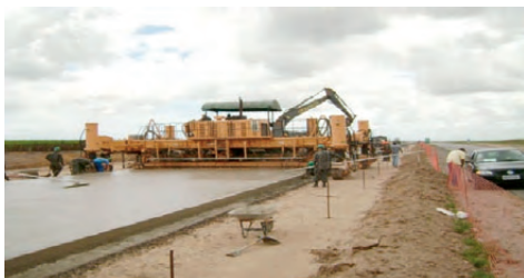
Execução de pavimentação em concreto de cimento
