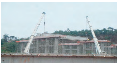
OAE 517 – Lançamento de vigas
