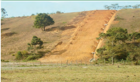
GASENE: CABIÚNAS – VITÓRIA: conclusão do enterramento do duto
