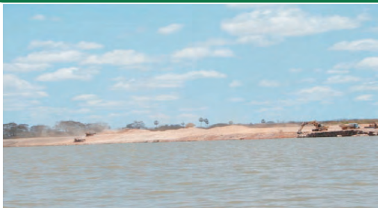
Serviço de retaludamento de margens em Barra-BA
