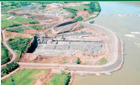
Vista das obras
