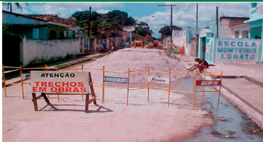
Construção de Rede Coletora
