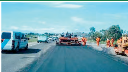
Execução de capa de rolamento
