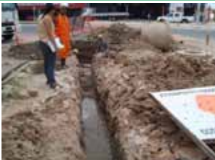
Assentamento de poço de visita Av. Osório de Paiva – Bacia SE-2
