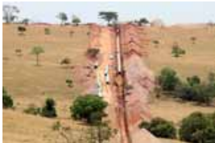
Assentamento da adutora de água bruta
