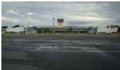
Terminal de Passageiros
