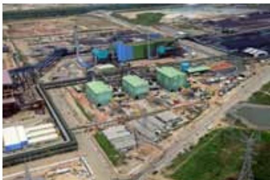
Vista Aérea do Empreendimento
