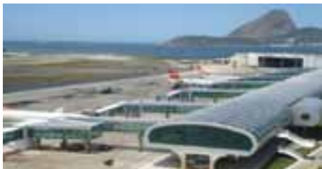
Terminal de Passageiros
