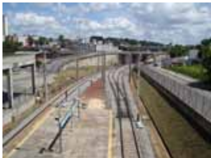
Acesso ao Pátio de Manobra da Estação Vilarinho
