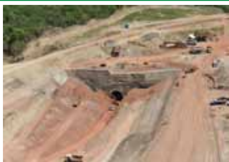
Lote 14 – Túnel Cuncas I
