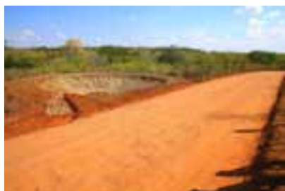
Bacia de dissipação - Recuperação Ambiental de Sub-bacia Hidrográfica - Rio Tigre/BA
