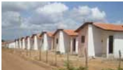
Construção de unidades habitacionais
