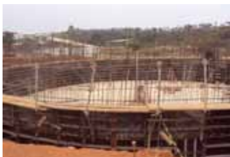
Execução dos filtros – ETE em Pedro Leopoldo
