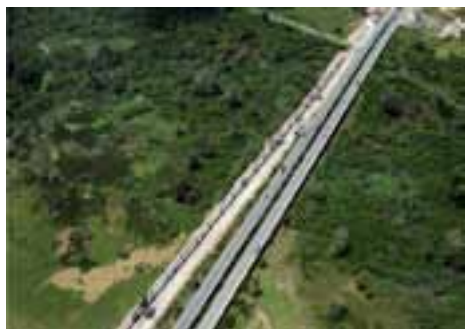
Adutora de Água Tratada
