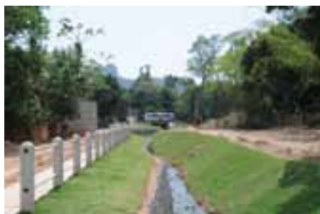
Retificação do canal Entre Rios
