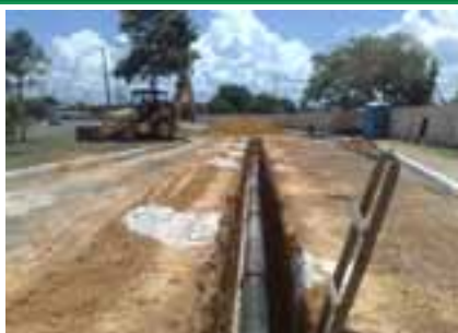
Adutora em execução
