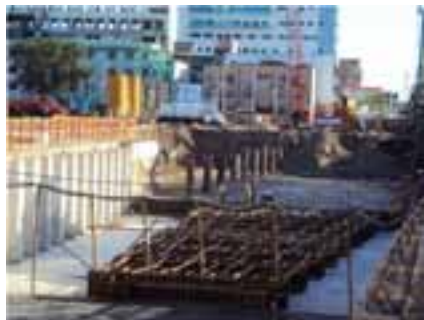
Obras na Estação Lagoinha
