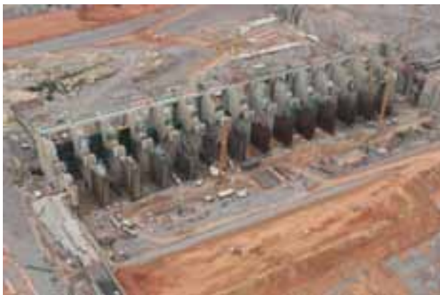
Vista Jusante - Vertedouro Principal
