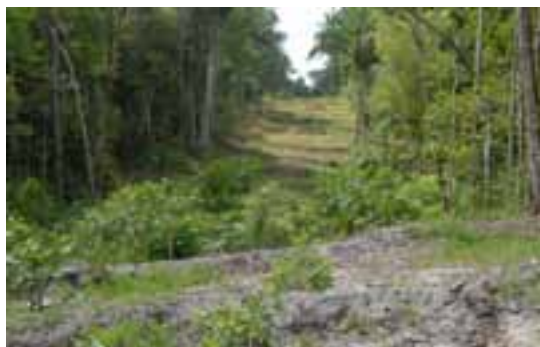
Faixa do duto já recomposta
