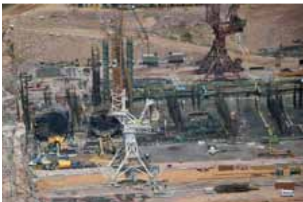
Casa de Força
