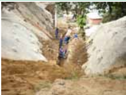
Contenção de encosta no Bairro Cruzamento
