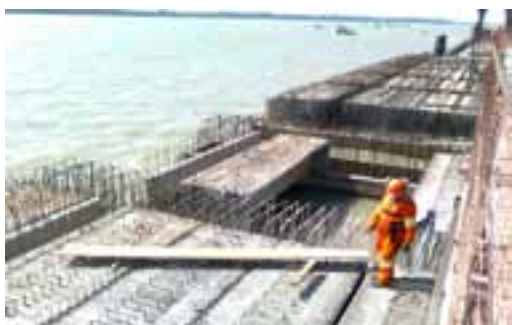
Construção do Berço 100
