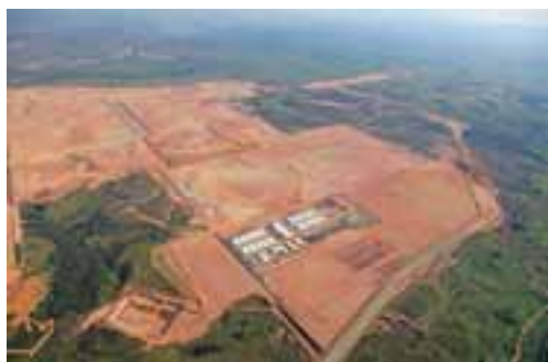
Terraplanagem e Canteiro de Obras
