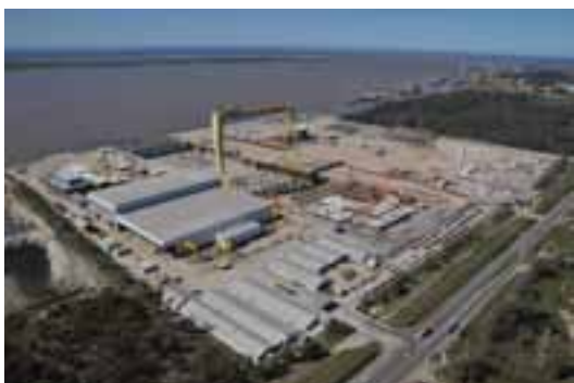
Estaleiro Rio Grande – Dique Seco e Oficinas
