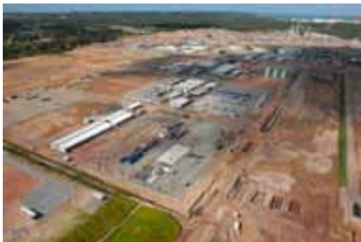
Canteiro de Obras e Tubovias
