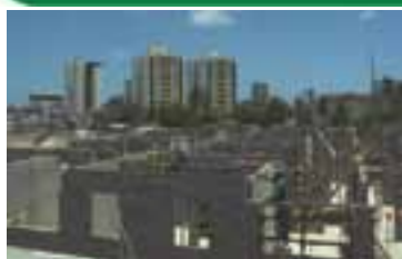
Construção de unidades habitacionais
