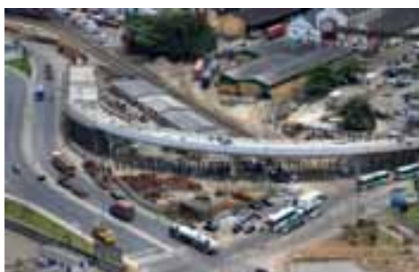
Viaduto Praça da Santa
