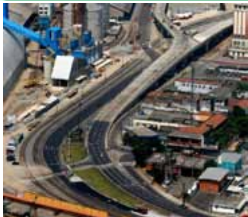
Vista aérea do viaduto
