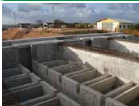
Ampliação da ETA Gramame
