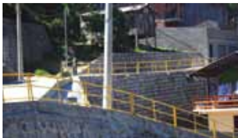
Muros de contenção e pavimentação de acessos
