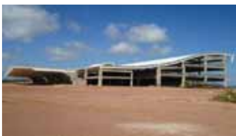
Construção novo Terminal de Passageiros
