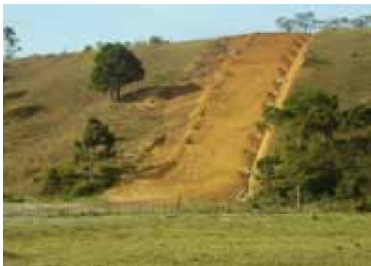
GASENE: Cabiúnas-Vitória – conclusão do enterramento do duto
