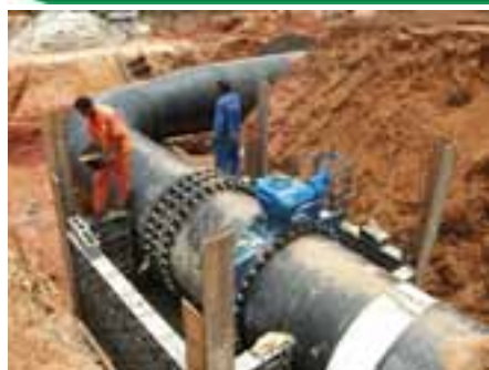
Conexão para colocação de chaminé de equilíbrio
