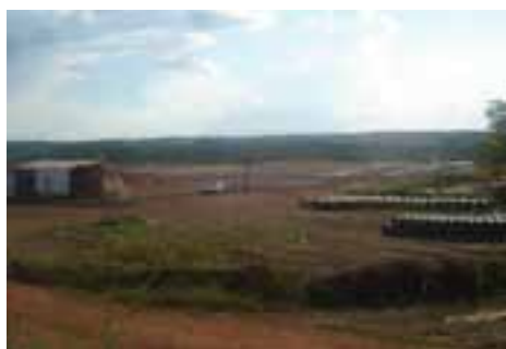
Canteiro de Obras
