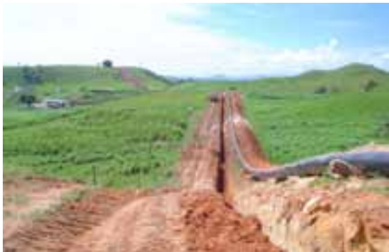
Gasoduto Campinas - Rio
