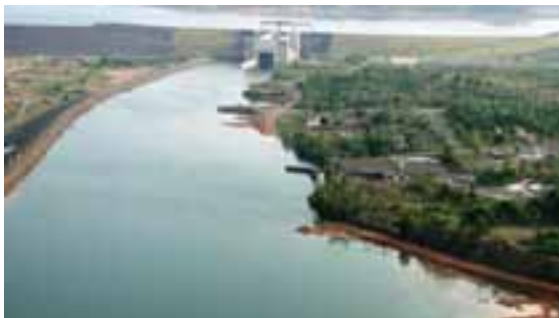
Vista a jusante da Eclusa 1 com o canal cheio
