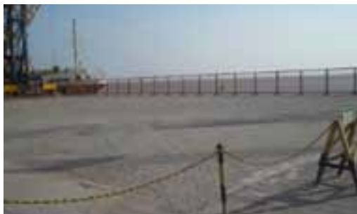
Berço 102 – Conclusão do piso em bloquete
