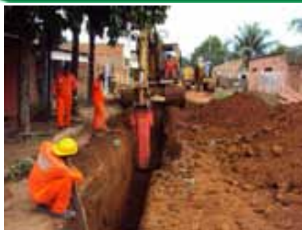
Rede coletora em execução
