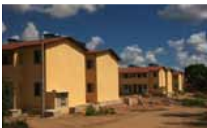
Construção de 400 UH em Camaragibe
