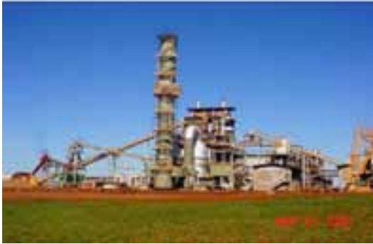
Vista geral da usina
