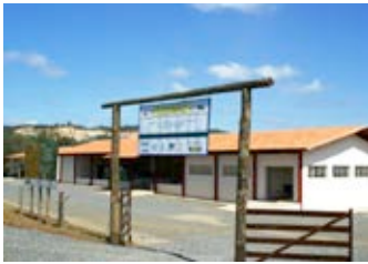
Centro de referência em área degradada Arcos/MG
