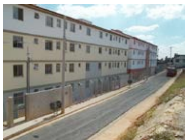
Vista UH Rua José Laerte – Pedreira Prado Lopes
