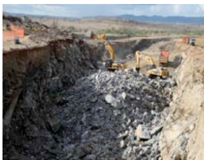
Escavação do canal
