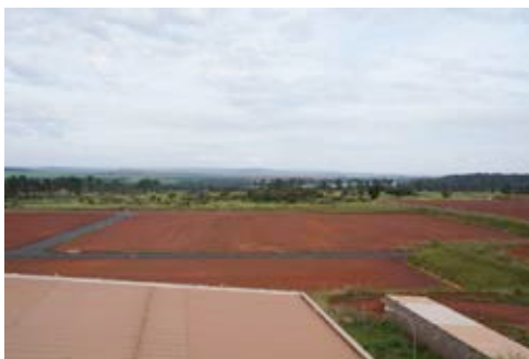
UFN V – Terraplenagem
