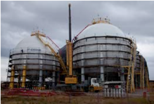
Montagem das esferas – COMPERJ
