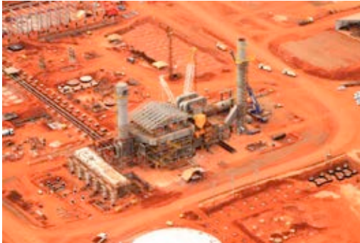
Construção e montagem do forno
