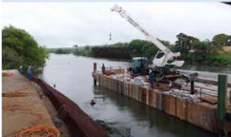
Canal de Igarapé – Detonação para remoção de pontos altos no canal
