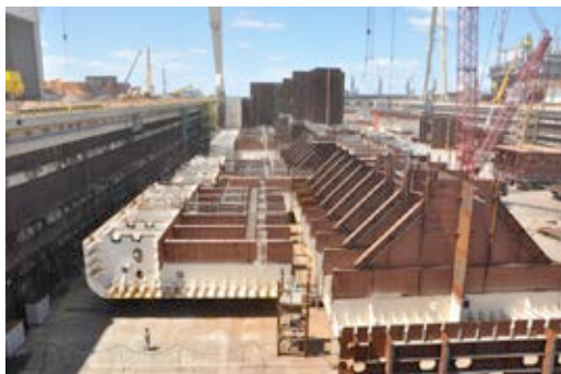
Edificação dos blocos da P-66 dentro do dique seco
