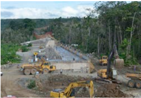
Tomada d'água – lançamento do concreto compactado a rolo
