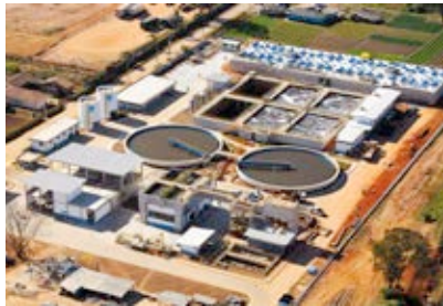
Vista geral da ETE São João obras concluídas
