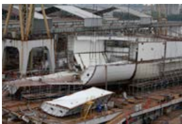
Construção do navio gaseiro – PROMEF II Lote 5
