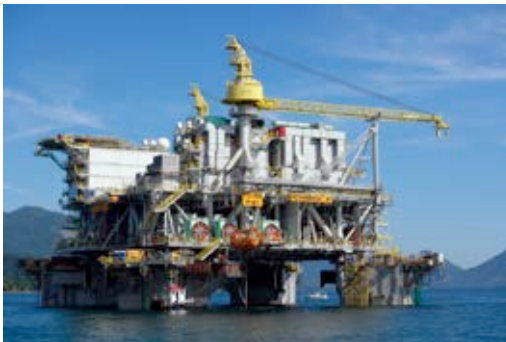
Montagem do Topside da P-61 sobre o casco
