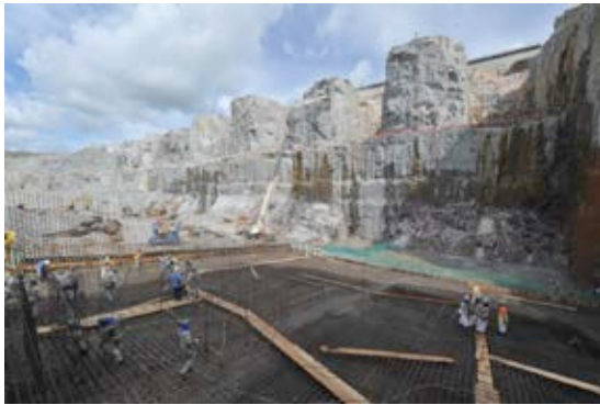
Sítio Belo Monte - Armação e Concreto
