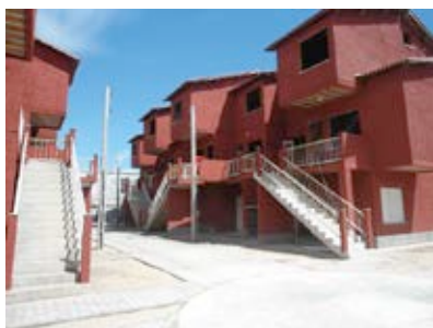
Unidades habitacionais – Terreno 2
