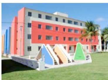
Habitacional 2 – Via Mangue – Recife/PE
