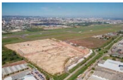
Construção do novo Terminal de Cargas
