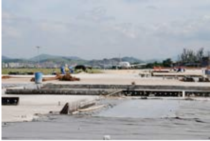
Recuperação e revitalização dos Sistemas de Pistas e Pátio
