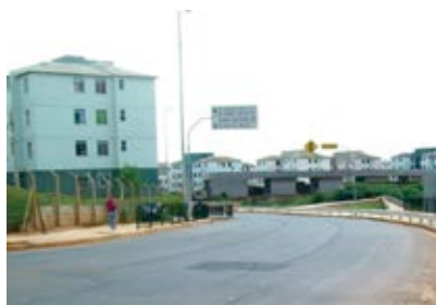
Vista UH e Centro Comunitário em construção
