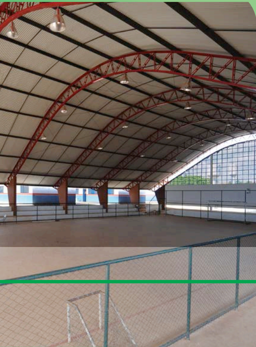
Quadra da Escola Municipal Érico de Souza, Águas Lindas | GO
