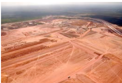
Terraplenagem da Refinaria Premium I
