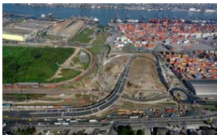
Vista da obra
