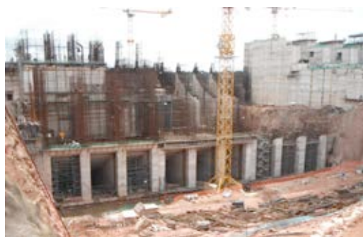
Casa de força – vista jussante
