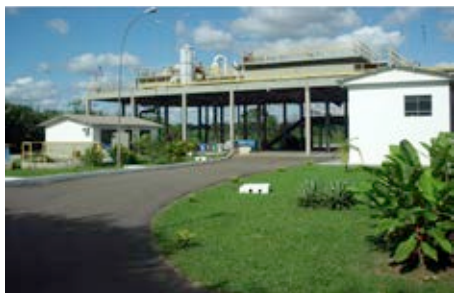
ETE São Francisco
