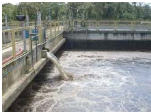
ETE Vicente Carvalho – Guarujá – tanque de aeração
