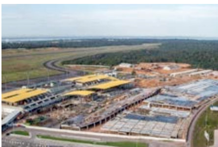
Reforma e ampliação do TPS
