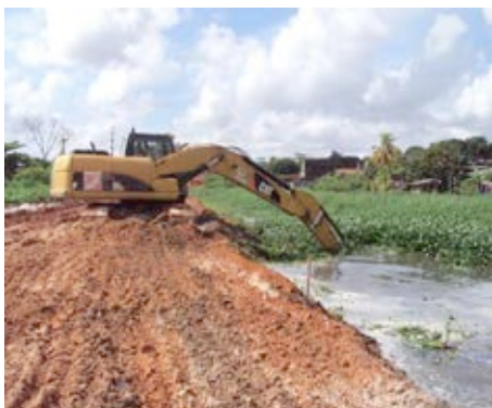
Remoção de solo mole - Canal Ariri
