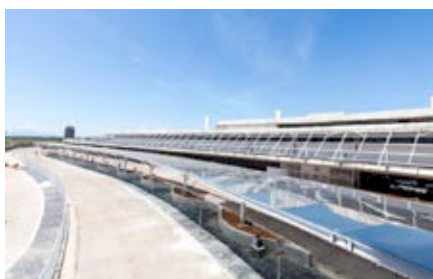
Reforma e modernização do TPS
