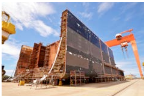
Construção dos blocos do navio Dragão dos Mares
