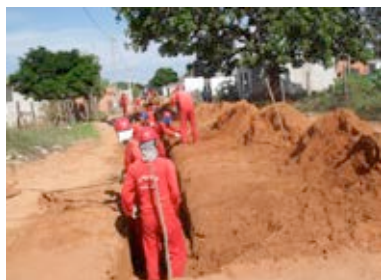
Assentamento de rede coletora – Lontra/MG
