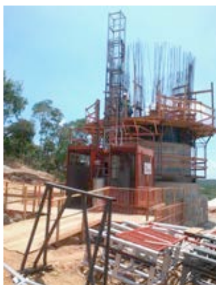
Chaminé de equilíbrio da adutora de água bruta
