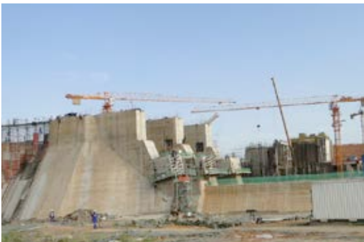
Vertedouro – vista geral
