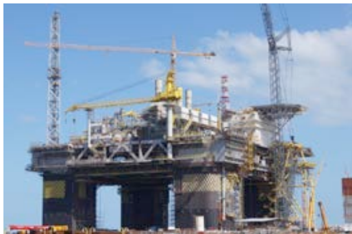
P-55 no cais de acabamento
