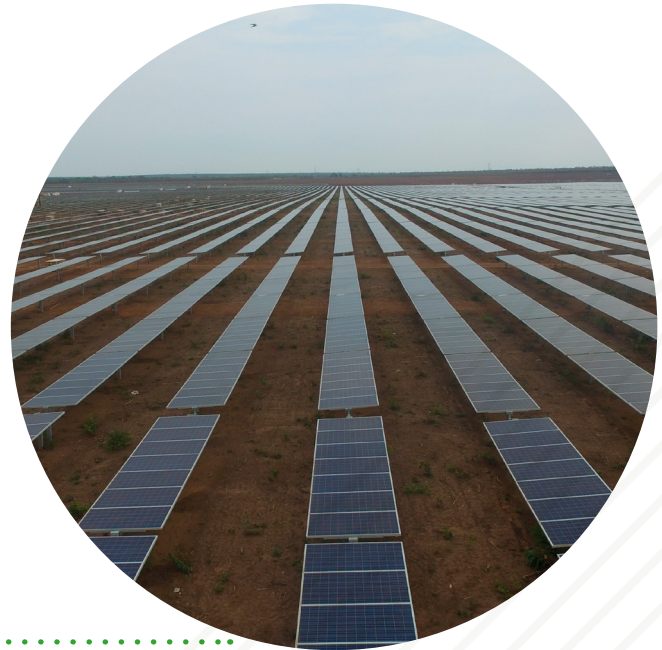
Usina Fotovoltaica Ituverava 1 (em obras)
