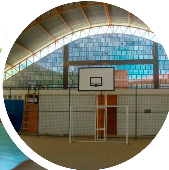
Quadra escolar coberta com vestiário - Adrianópolis (PR)
