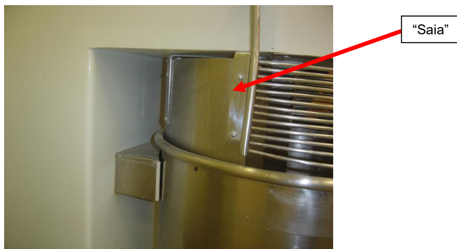
Figura 72 – Detalhe da “saia” na amassadeira
