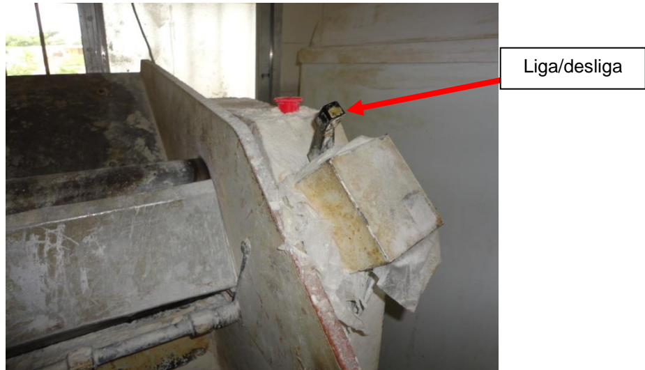
Figura 57 - Dispositivo de ligar/desligar a máquina permite o acionamento acidental
