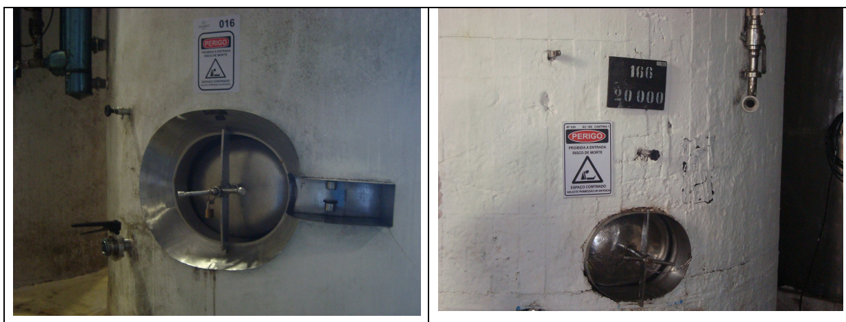
Figuras 11 e 12 – Bloqueio e sinalização dos acessos aos espaços confinados
